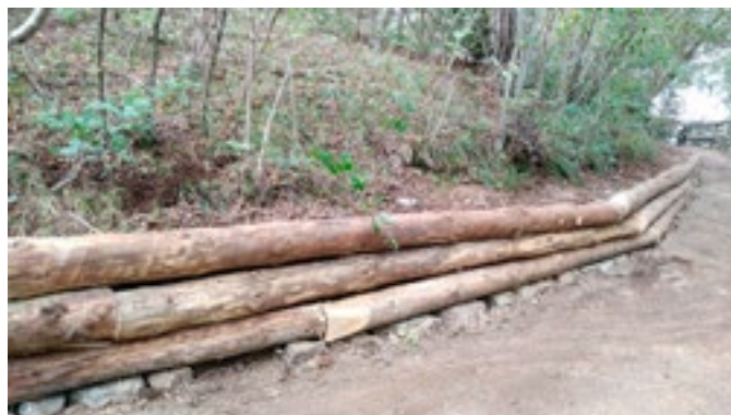
Dos Gustinaci, sistemazione percorso per il belvedere sulle palafitte
